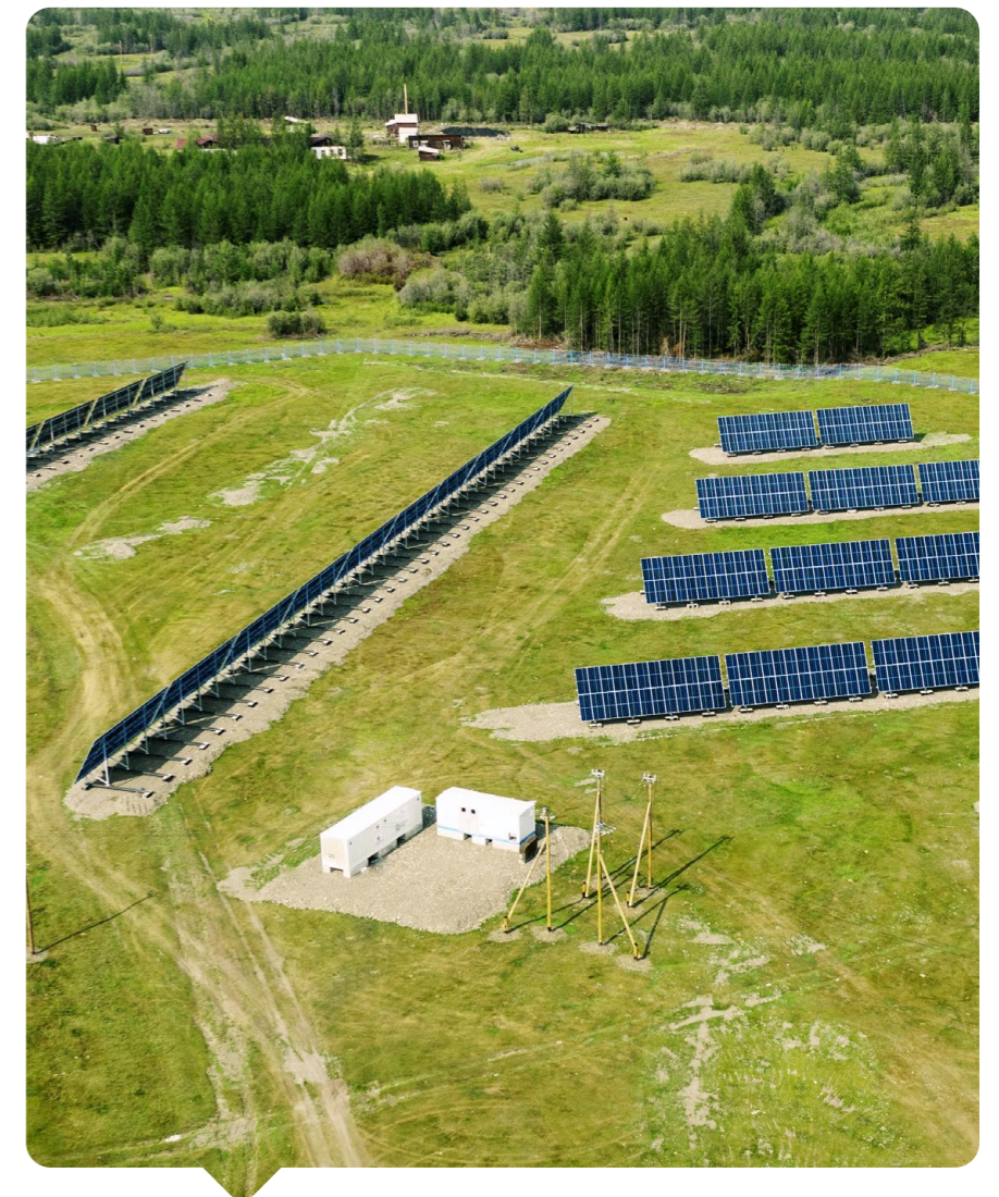
АГЭК в с. Хонуу введен в работу в 2022 году
